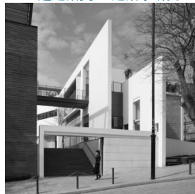
2006 Stanley Municipal Services Building 赤柱市政大廈 HKIA Medal of the Year 香港建築師學會全年建築大獎
