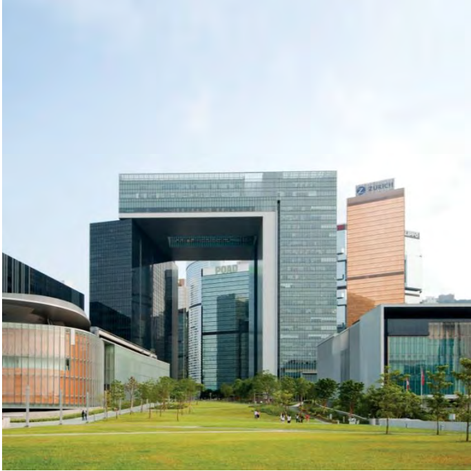
HKIA Merit Award of Hong Kong – Community Building 香港建築師學會境內優異獎 – 社區建築 Tamar Development Project 添馬艦發展工程
