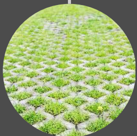
Grasscrete 多孔透水路面
